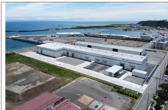
プラニック様 プラスチックリサイクル工場外観 (静岡県御前崎市 2022年10月工場稼働)
